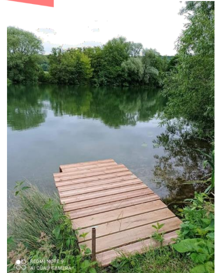
Aménagement d'un ponton en bois
