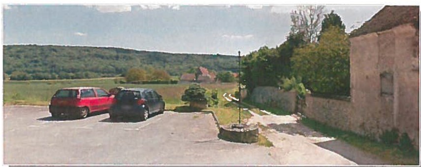
Vue depuis la rue Roubineau vers le chemin de la grande maison
